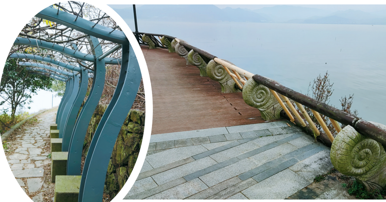
▲围栏已修复，后期将刷漆。 ▲生锈的花架已刷漆处理。（邱韵 摄）
