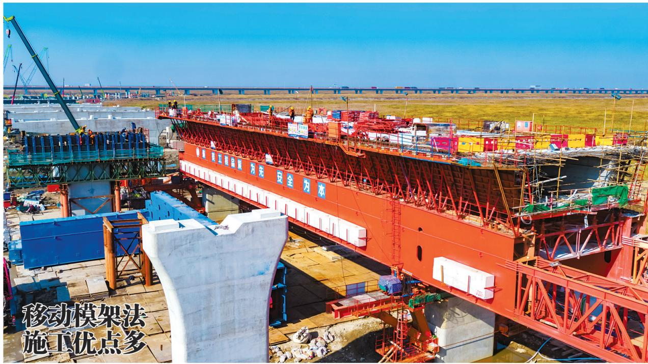
我市在十一塘高速公路工程（一期）首次采用移动模架法施工工艺，完成高架桥现浇箱梁施工。该工艺在作业时无需在桥下设置模板支架，更适用于海域滩涂区的环境。该高速公路工程是省重点项目，连接杭州湾跨海大桥和杭州湾二通道（沪甬跨海通道）。图为昨日航拍镜头下已完成浇筑施工的58米首跨箱梁。（徐能 卓松磊 摄）
