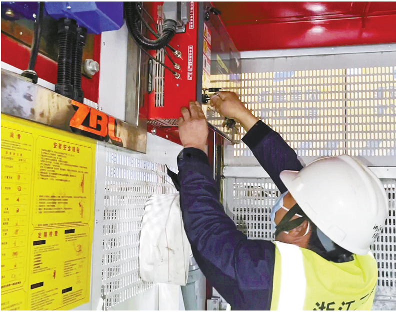
浙江二建工作人员在工地检查设备。(何峰 摄)
