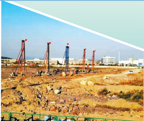
12月3日，宁波片区梅山国际冷链供应链平台项目正式开工。
