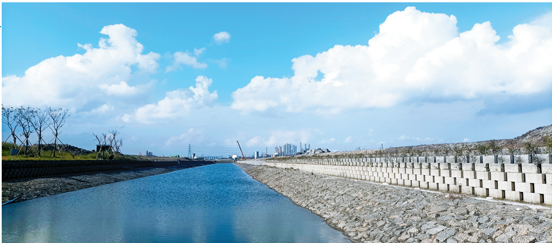
▲镇海区海岸带生态修复与海塘安澜（一期）工程。
