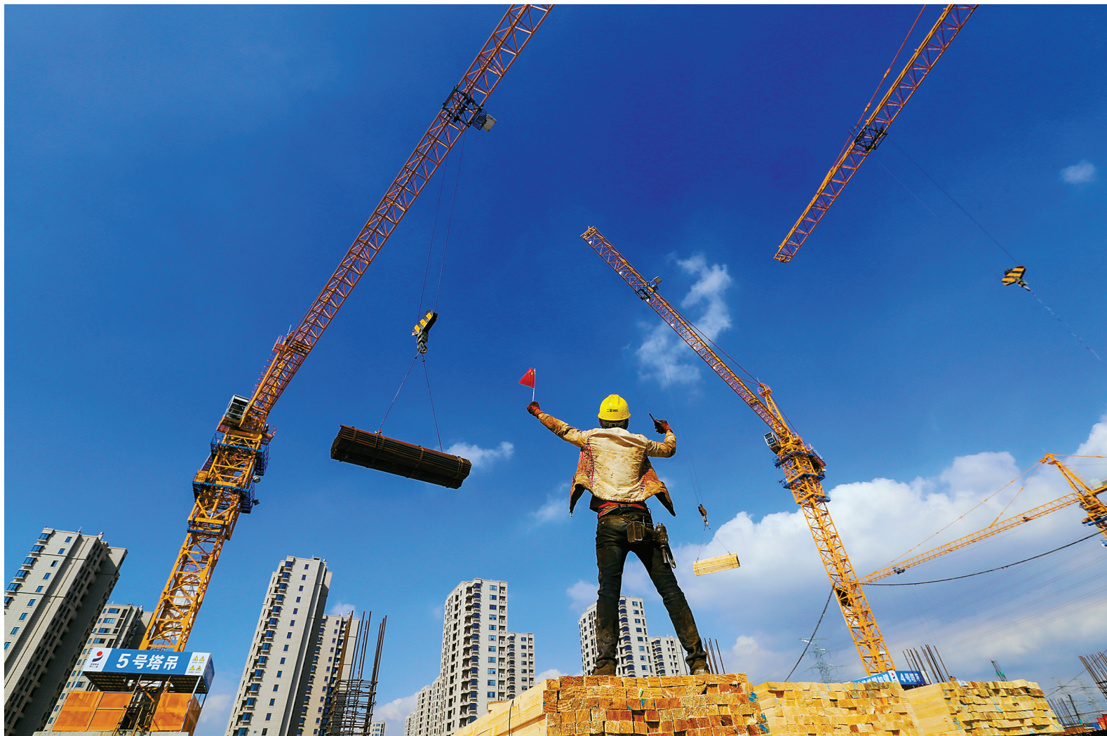
新年新气象。图为一名建筑工人在指挥塔吊。(竺仕宝 摄)
