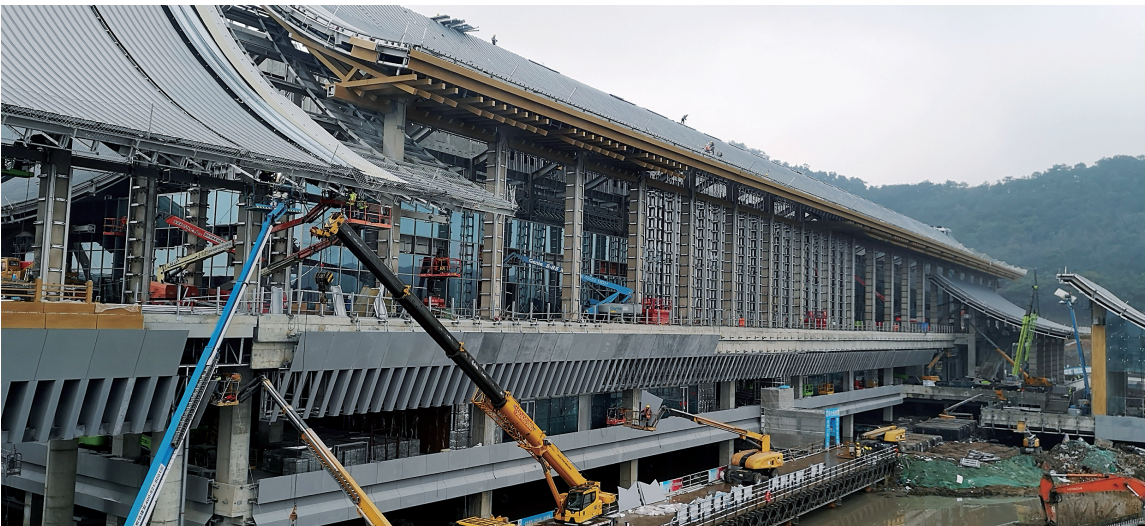
宁波国际会议中心项目施工现场。
