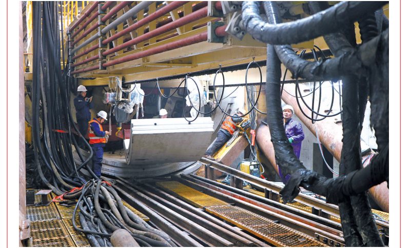
盾构施工现场。(市住建局供图)
