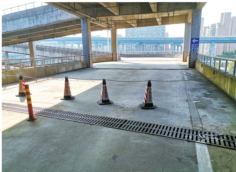
三楼停车场出入口用铁链锁住。(石景 摄)
