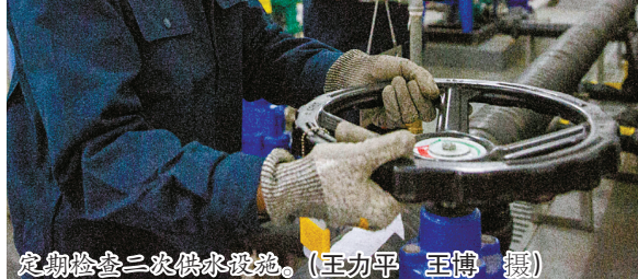
定期检修二次供水设施。(王力平 王博 摄)
