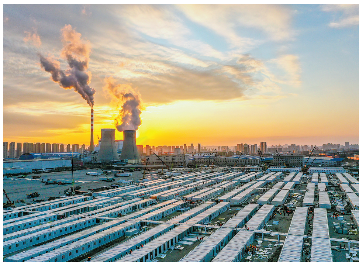
3月20日，记者在吉林市高新南区隔离方舱建设现场看到，5000余名工人和百余台工程机械加班加点同时施工作业，为工程建设提速。这是拍摄的吉林市高新南区隔离方舱建设现场（无人机照片）。（新华社记者 张楠 摄）
