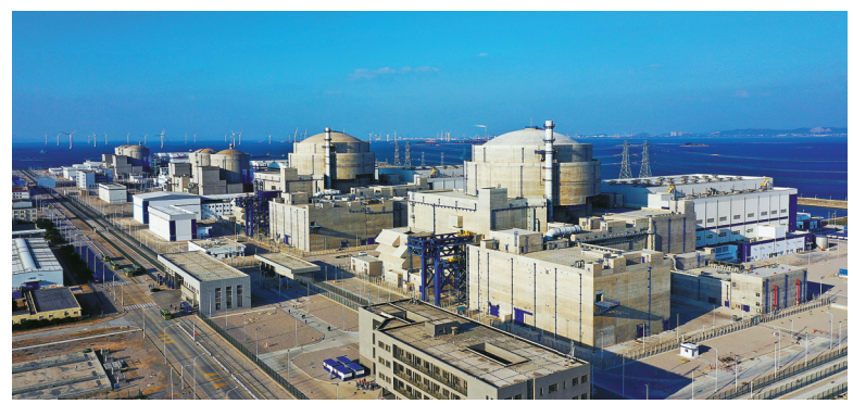
福清核电6号机组(右一)、5号机组(右二)(无人机照片)。(新华社发)
