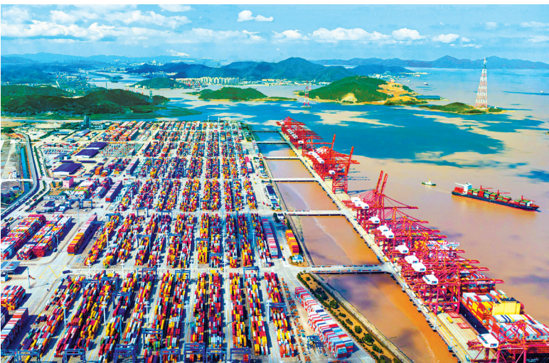
宁波舟山港穿山港区。
