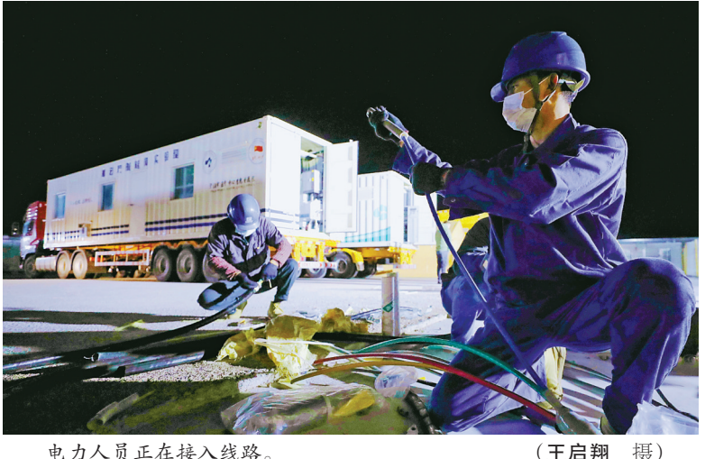
电力人员正在接入线路。(王启翔 摄)
