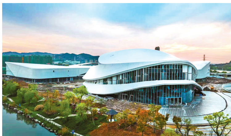
建设中的余姚市公共文化中心
