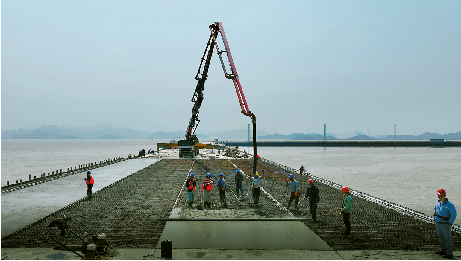
中交三航局的工人正在进行最后一根引桥的面层浇筑。
