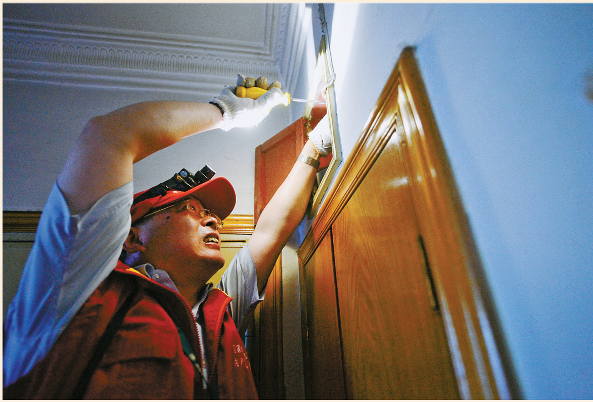
在慈溪市吉祥社区空巢老人家中,钱海军帮老人更换老旧的线路开关(2013年8月16日摄)。(新华社记者 徐昱 摄)
