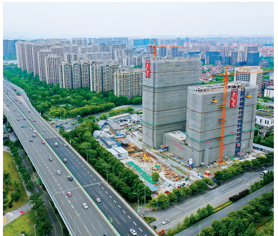
市疾病预防控制中心迁建项目顺利结顶，预计明年3月完工。
