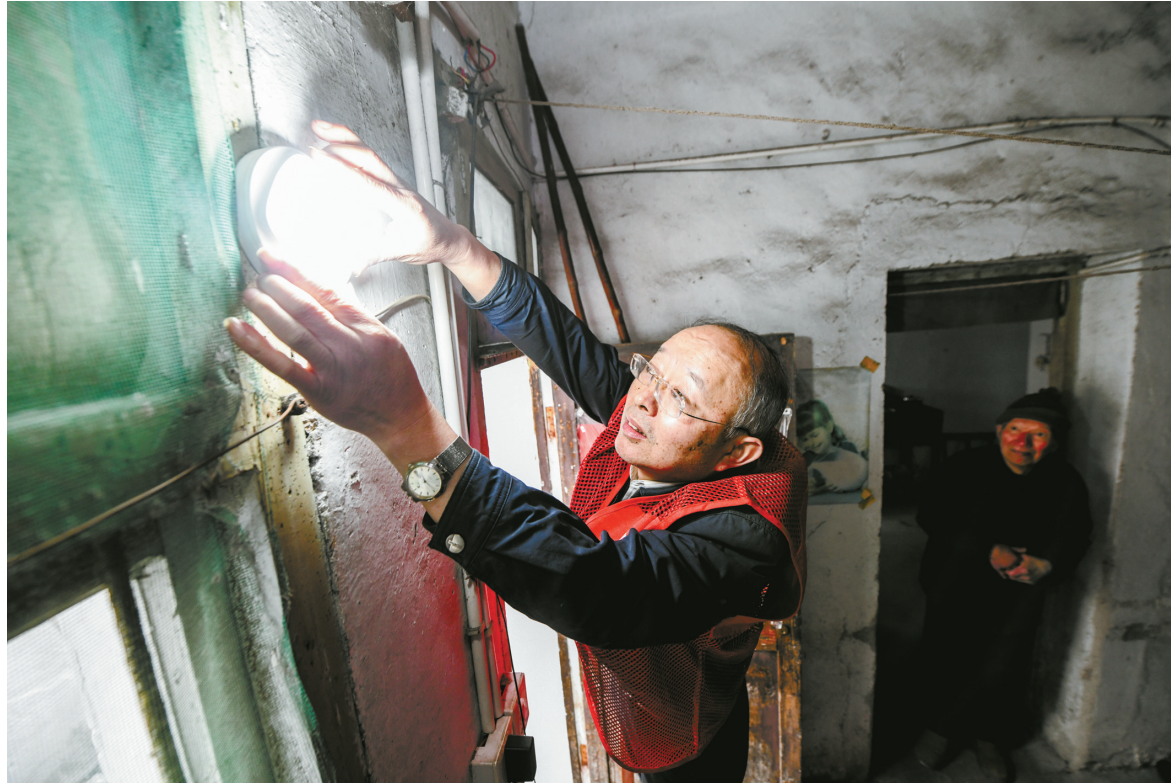
2021年3月3日，钱海军为结对老人应久昌进行室内电气线路检修。
