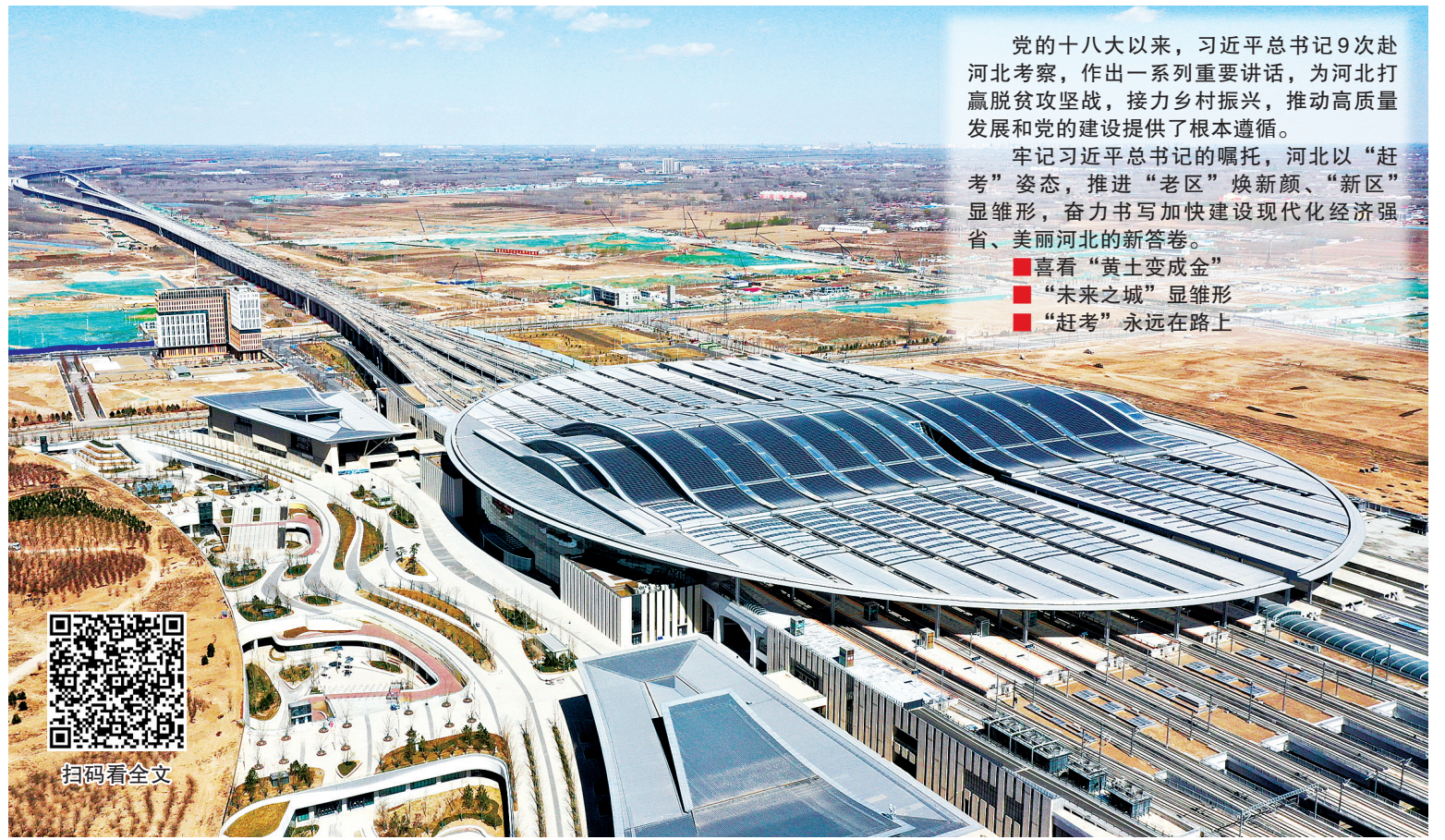
雄安新区雄安站（2022年3月31日摄，无人机照片）。
