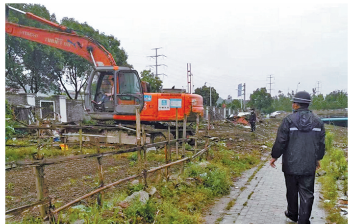
现场挖掘机正在进行清理工作。(梅墟街道供图)
