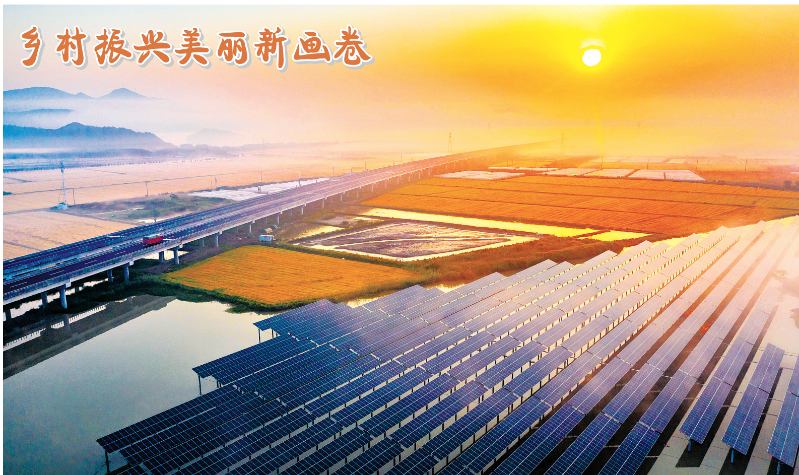
宁海作为首批部省共建乡村振兴示范县建设单位，近年来加大对农业农村基础设施建设的投入，进一步完善农田水利设施，加强高标准农田建设，加快城乡冷链物流设施建设，稳步推进“四好农村路”建设，以基础设施现代化促进农业农村现代化。图为该县长街镇塘村“渔光互补”发电项目。（尤才彬 严龙 摄）
