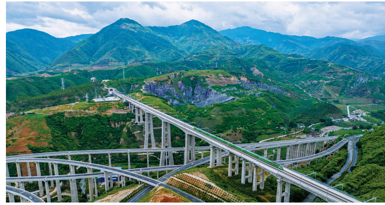
复兴号列车通过中老铁路南溪河特大桥(无人机照片,6月2日摄)。 6月3日,中老铁路开通运营满半年,客货运呈现量质齐升态势,国际黄金物流大通道作用日益显现。截至2日,中老铁路累计发送旅客327万人次,其中国内段286万人次、老挝段41万人次;发送货物403万吨,其中跨境货物64.7万吨。 (新华社记者 江文耀 摄)
