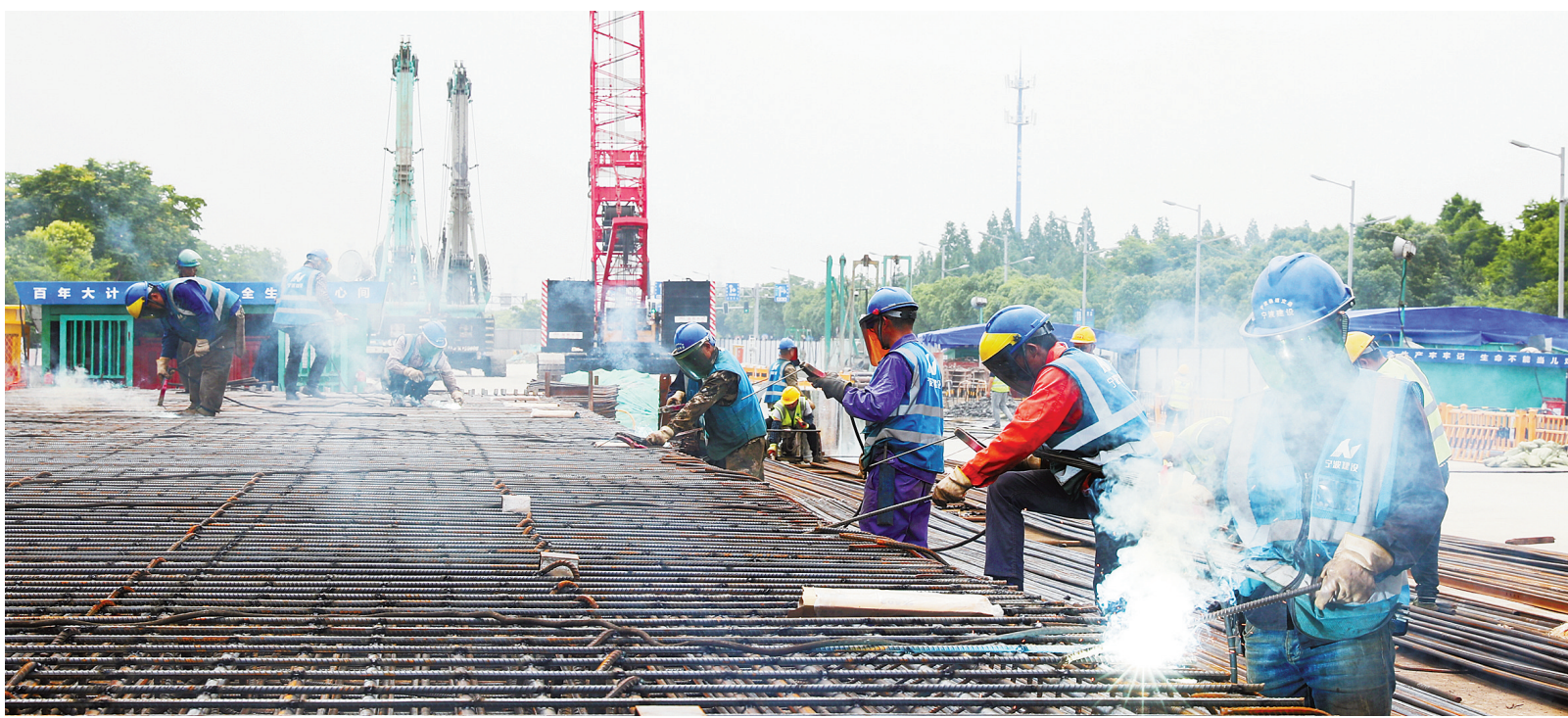
7号线贵驷站掀起施工大干热潮
