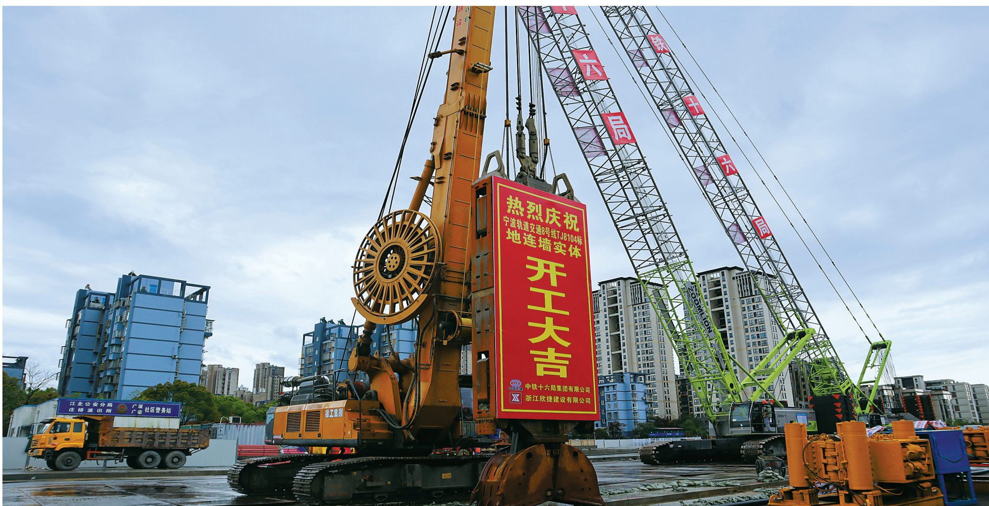
8号线云飞路站开工现场
