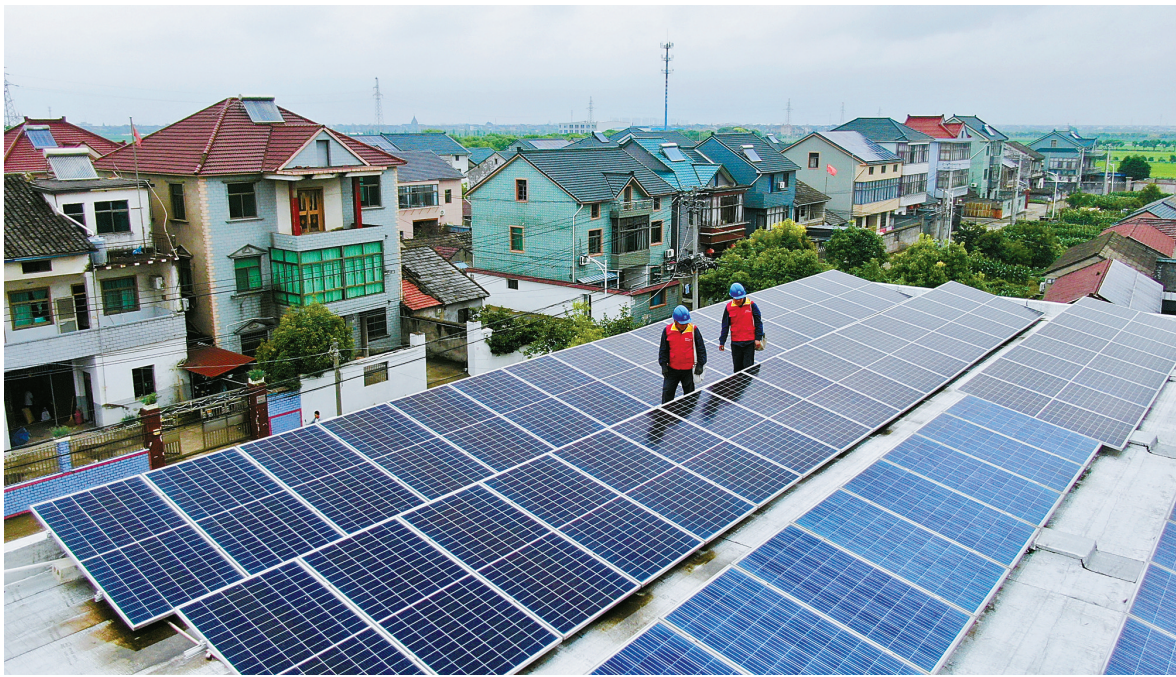
技术人员巡查屋顶光伏。
