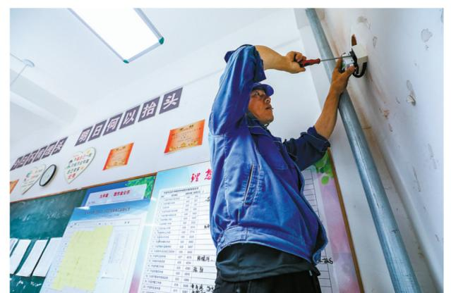
6月12日晚,国网宁波市鄞州区供电公司员工加班加点在云龙中学增设电源点,加装空调,让考生可以清凉备考,决战中考。据统计,他们共完成了鄞州区5个考点、219台空调的接电安装。(通讯员 洪浩哲 摄)
