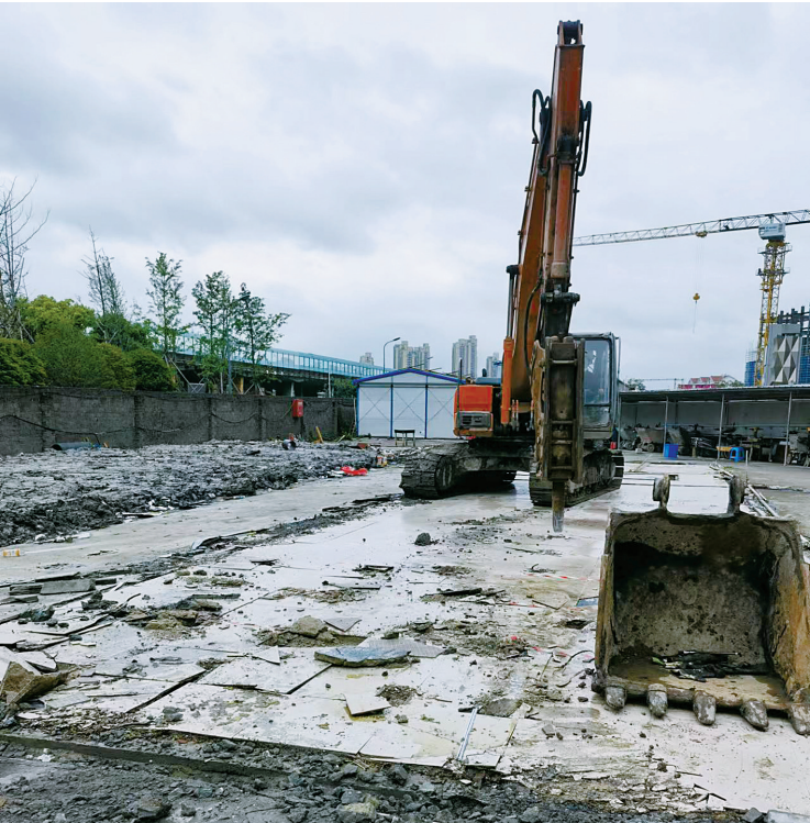
鄞州区潘火街道某某房地产有限公司非法占地案拆除现场
