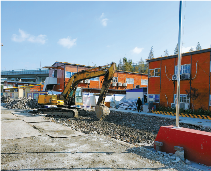
海曙区古林镇某某建设有限公司非法占地案拆除现场
