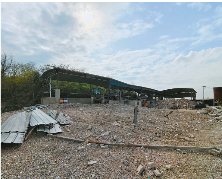
北仑区霞浦街道某某建筑材料有限公司非法占地案拆除现场
