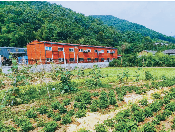
象山县涂茨镇泊戈洋非法占地案土地现状
