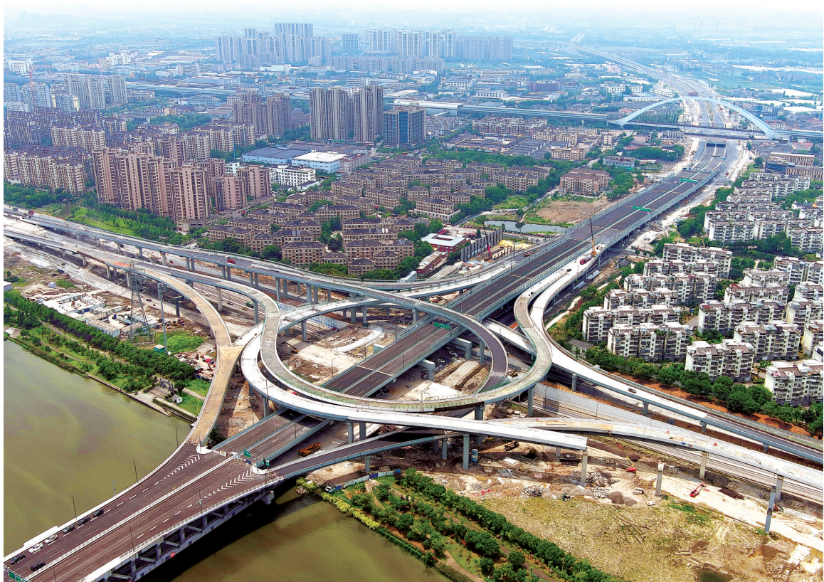
西洪大桥及接线工程全长4.5公里，连接海曙和江北。
