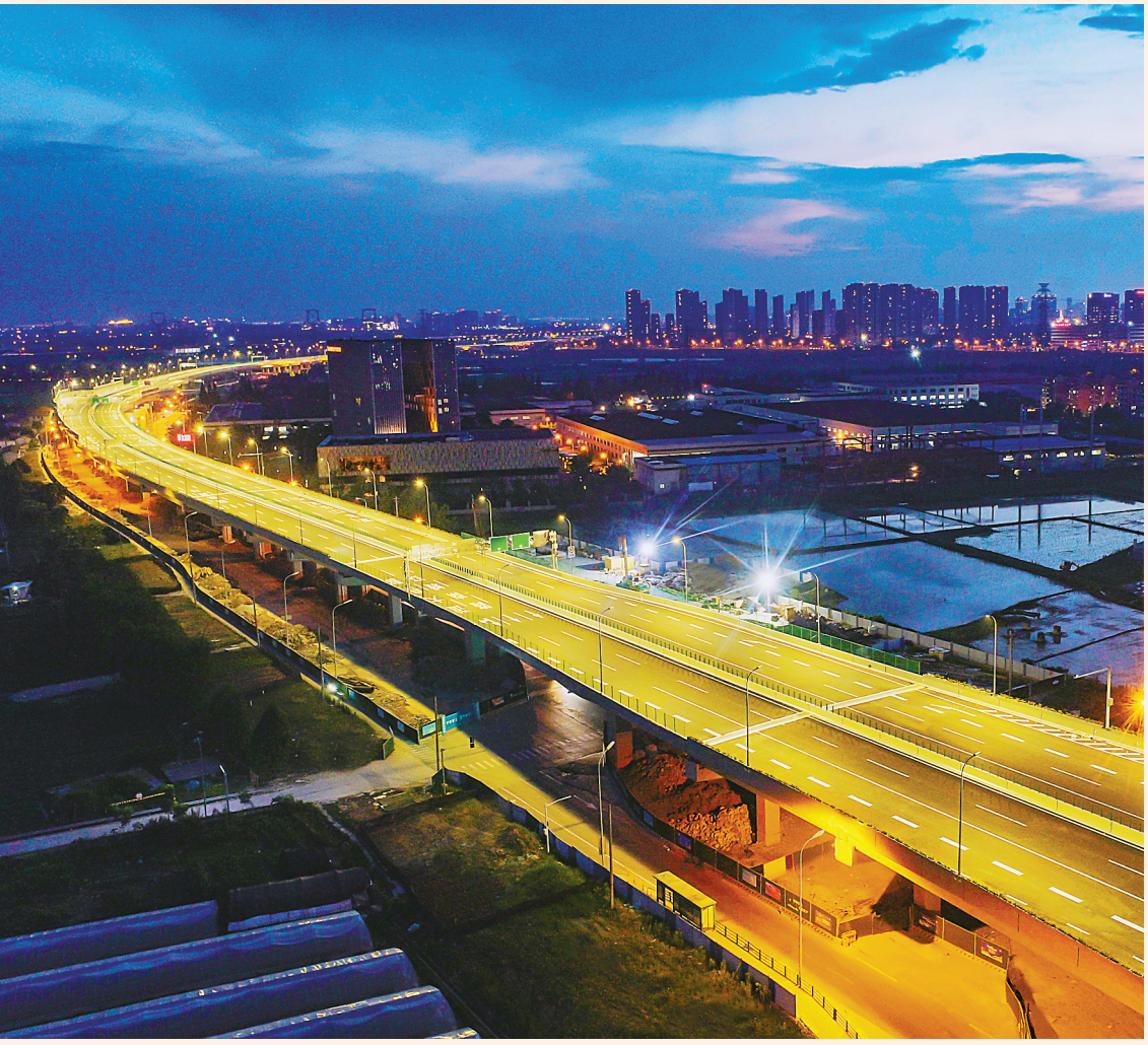
环城南路西延工程和西洪大桥及接线工程的建成通车，使姚江两岸更加融合。
