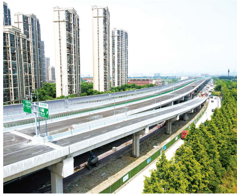
鄞州大道-福庆路（东钱湖段）一期工程。
