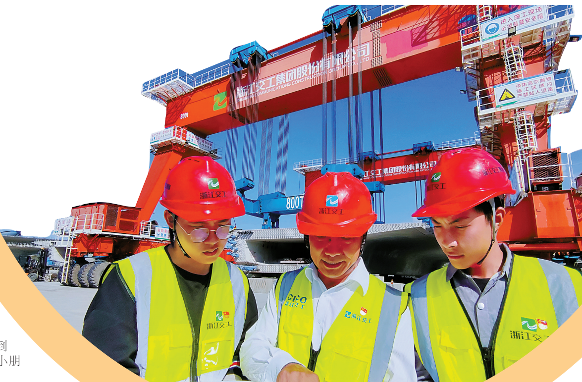
浙江交工杭甬复线宁波一期S4合同段整孔箱梁预制中心安全负责人、共产党员邵明新(中)和员工一起在现场讨论安全事项。(张涛 王鹏 摄)
