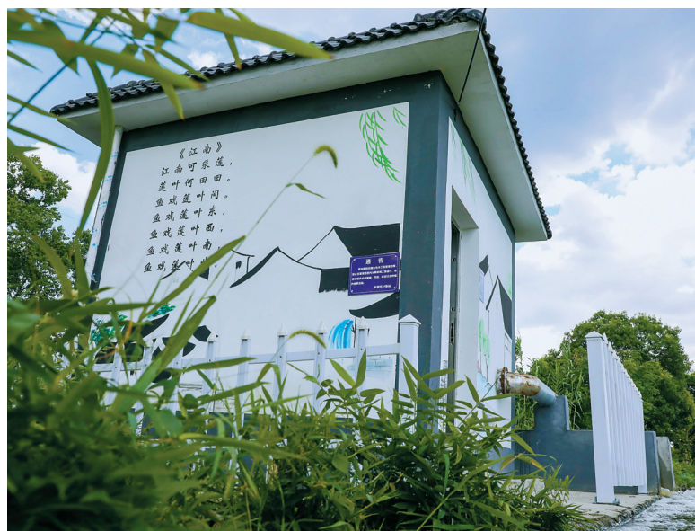
提升改造后的泵站机埠。
