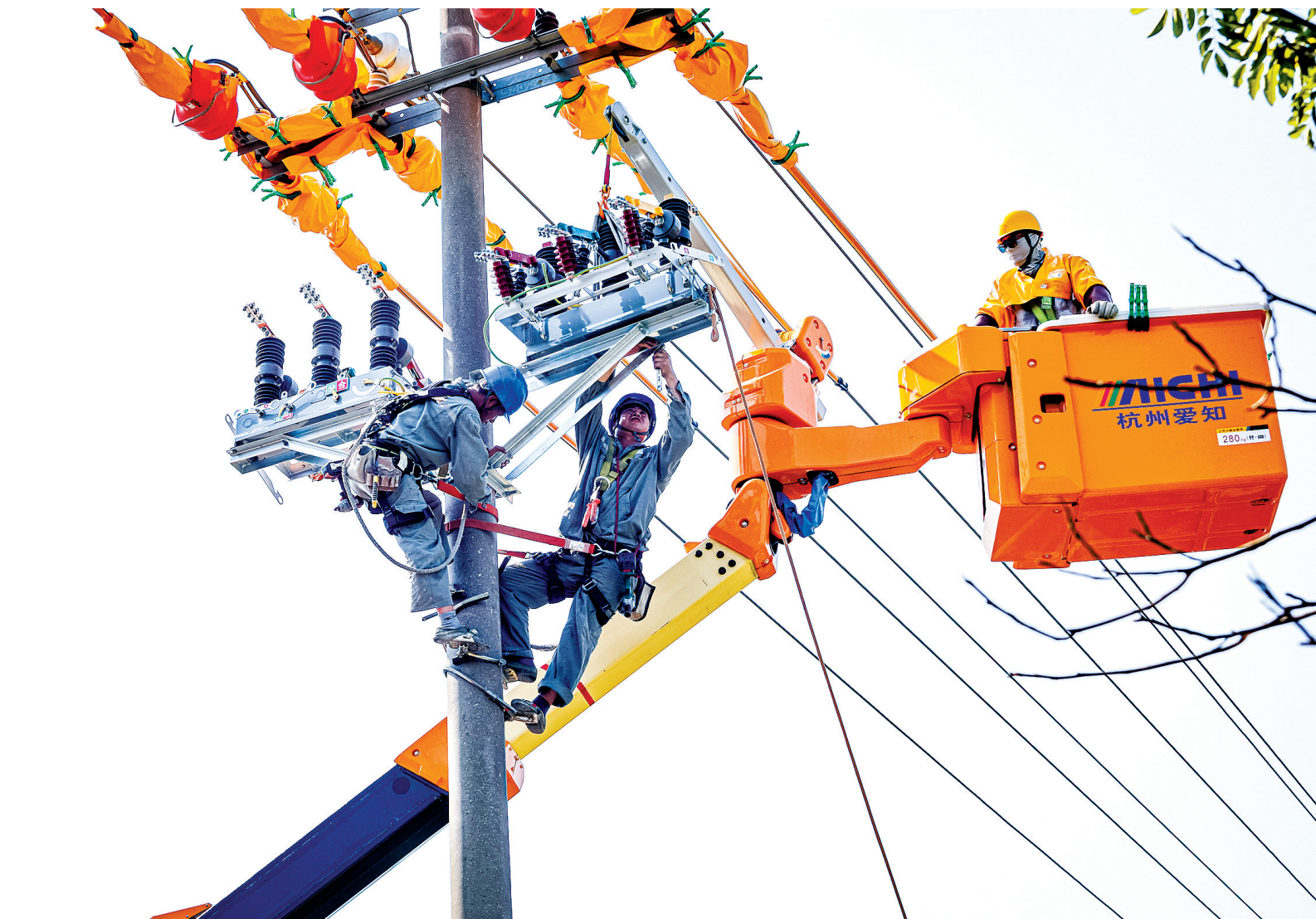
近日,国网宁波市鄞州区供电公司员工在东吴镇同心路鄞县大道路口不停电安装柱上开关,在保障高温天气电力供应的同时,为鄞县大道拓宽工程做好电力支撑。(洪浩哲 摄)
