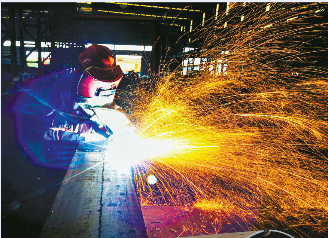
拼装班组焊工进行破弧气刨。
