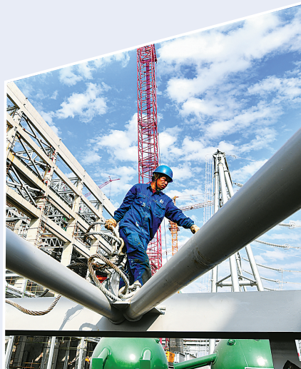
工人在吊装成品构件。
