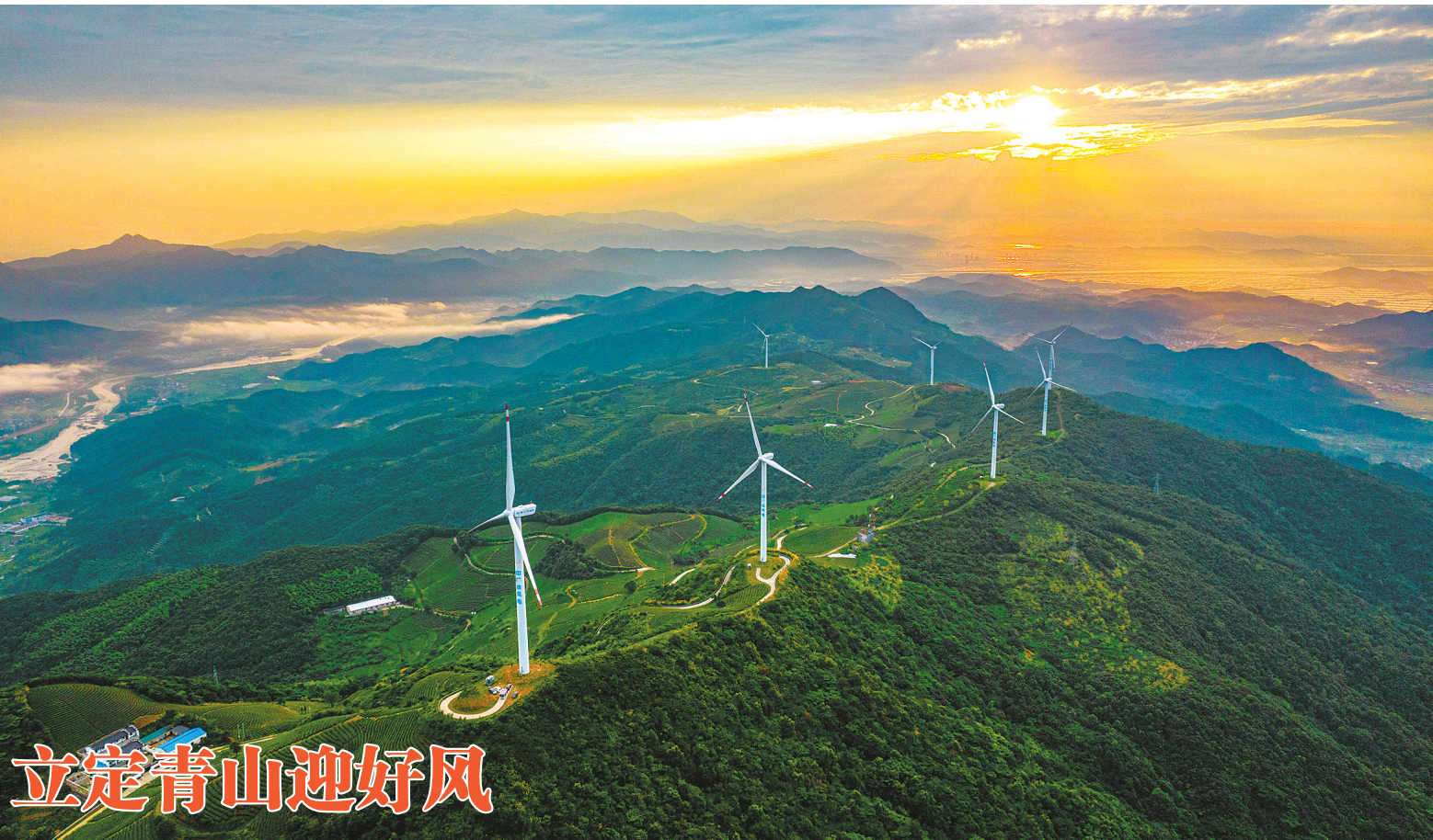
苍山如海,朝霞似锦,宁海望府楼山上的茶园和风电场被旭日映照得鲜艳夺目,这里是该县乡村旅游的网红打卡地。十里风车路是专门修建的通往风机位置的山路,横跨跃龙、一市等乡镇街道,成为宁海一条崭新的风景线。 (徐铭 严龙 摄)
