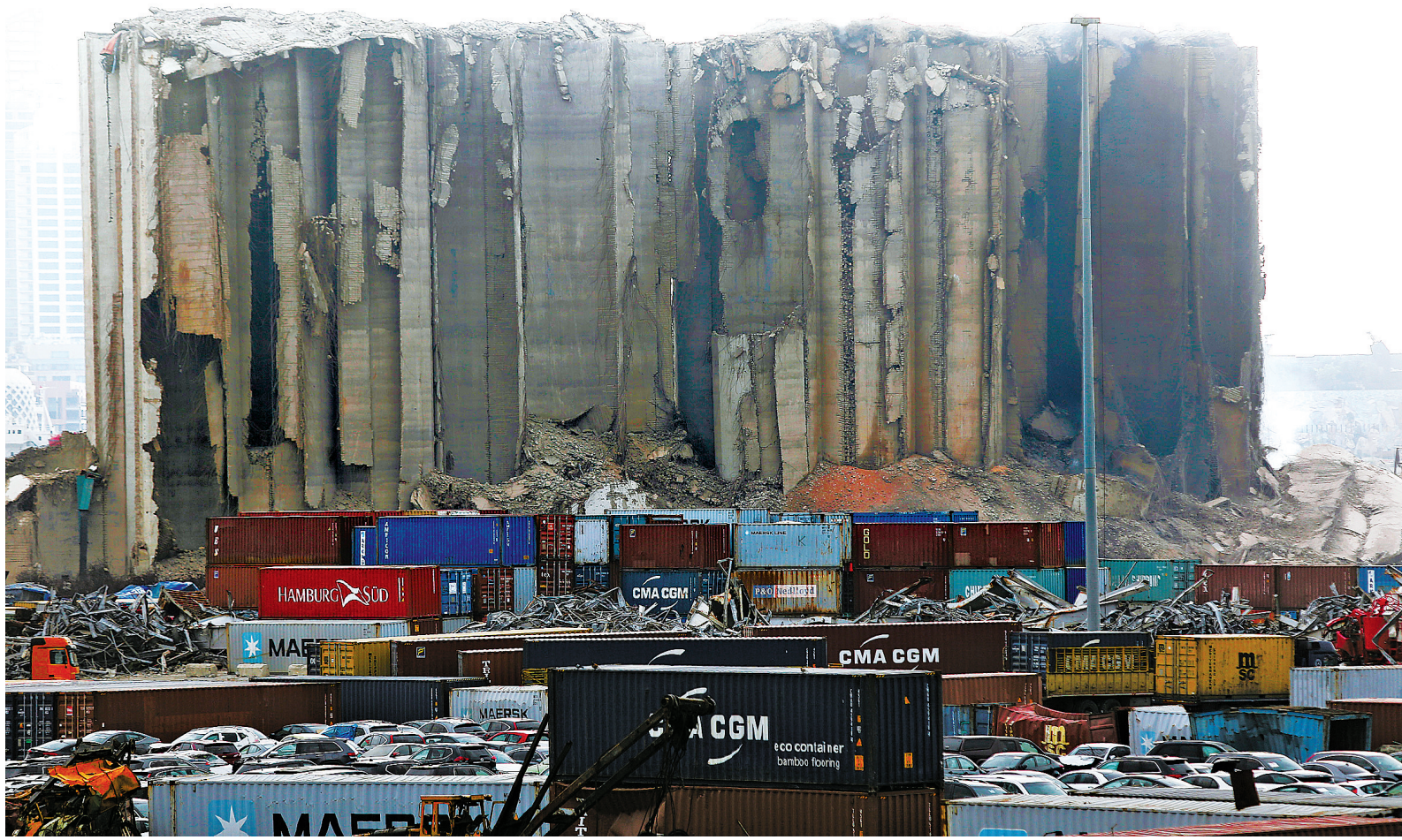
这是7月31日拍摄的部分坍塌的黎巴嫩贝鲁特港口粮仓。
