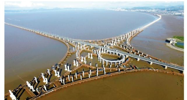
前天下午4时30分，随着位于杭甬高速复线宁波段一期工程B闸道的最后一根桩基浇筑完成，该工程1745根海域桩基全部顺利完工，全面进入桥墩建造和梁架冲刺阶段。（董娜 宋旭东 吕奎元 摄）
