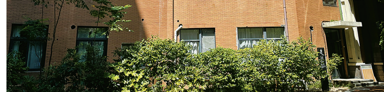
8月7日，鄞州凌波路嘉莱美整形医院外墙的窗已经封固。(廖业强 摄)
