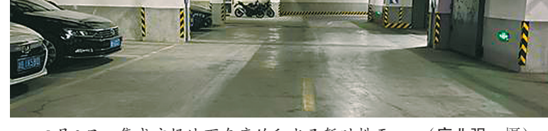
8月3日，集成广场地下车库的积水已暂时排干。(廖业强 摄)
