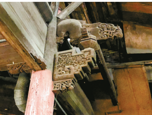
大殿采用抬梁与穿梁相结合的建筑结构
