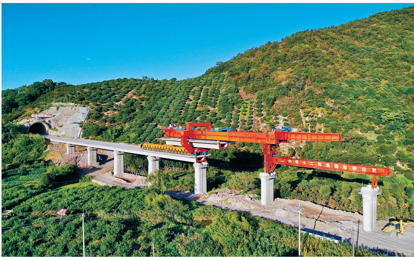
“一档起钩，各点位注意，开始喂梁。”昨天下午5:30，金甬铁路奉化段西坞街道河头村大桥施工现场，随着中铁十二局金甬架梁项目总工程师马建平一声令下，在架桥机、运梁车操作员的协同下，重650吨的预制箱梁缓慢又平稳地被喂入架桥机U型膛内……
