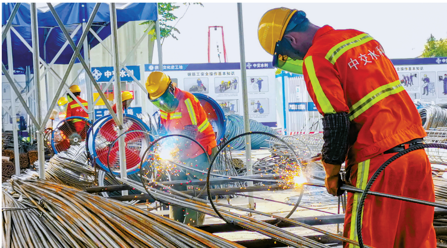
钢筋工正在作业中。
