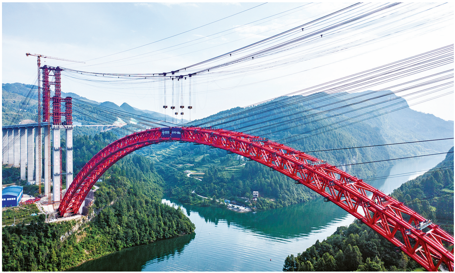
8月15日拍摄的德余高速乌江特大桥合龙现场（无人机照片）。
