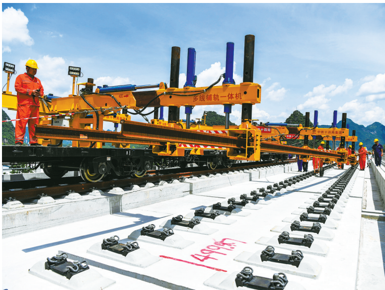
这是8月16日拍摄的贵南高铁广西段龙江双线特大桥铺轨作业现场。当日，在广西河池市，一台铺轨机将一段500米长钢轨铺设在贵南高铁龙江双线特大桥的无砟轨道上，标志着贵南高铁正式进入铺轨阶段。建设中的贵南高铁是我国“八纵八横”高速铁路主通道包头至海口通道的重要组成部分，设计时速350公里。（新华社记者 曹伟铭 摄）
