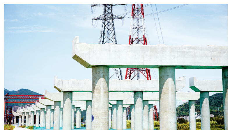
昨天，六横公路大桥舟山侧桩基全部施工完成。（张燕 何明芳 摄）
