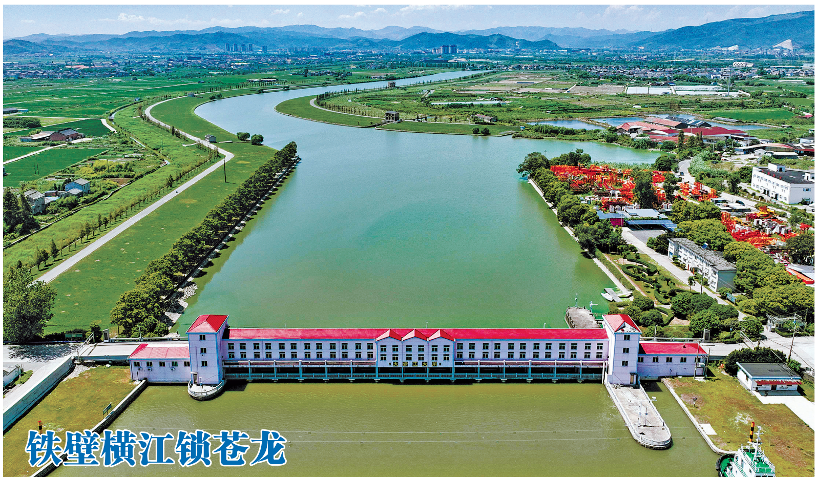
铁壁横江锁苍龙 今年7月和8月,鄞州区大嵩江大闸累计蓄水340万立方米,用于补充周边河网和农田用水,切实保障农业生产。大嵩江堤防一期是一项兼具挡潮阻咸、防洪排涝、蓄水抗旱功能的水利枢纽工程,防洪标准达到20年一遇。图为8月30日拍摄的大嵩江堤防一期工程。(严龙 王博 摄)
