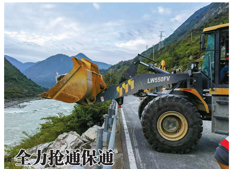
全力抢通保通 9月6日上午，工程机械在省道S217线沪石路快速通道K30二里坝段进行抢通作业。
