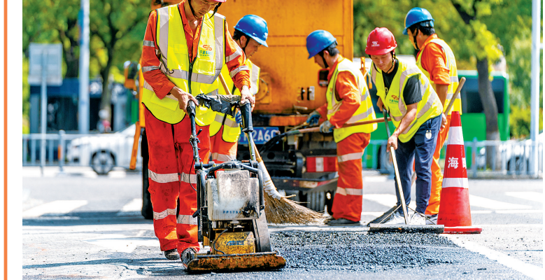
受连日降雨和积水影响,甬城不少沥青路面出现不少坑洞。昨天,趁着天气晴好,海曙区市政养护中心抢抓时机,安排养护单位对受损路面开展坑洞修复工作,保障市民出行安全。(徐能 忻之承 摄)
