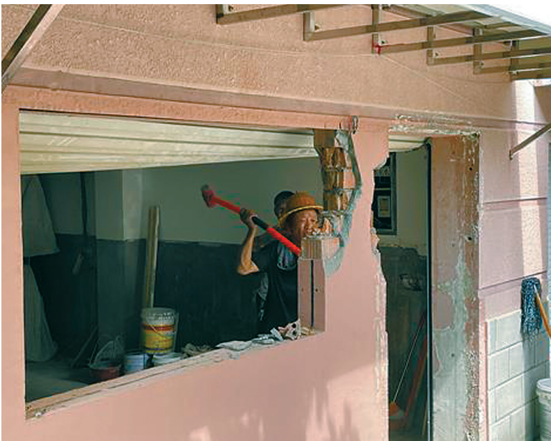
7月15日，福明家园一期23幢车库的违建墙体被拆除。（廖业强 摄）
