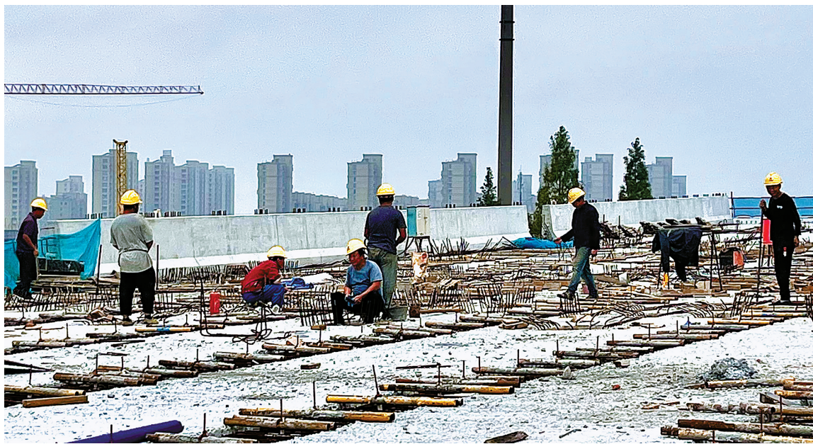
鄞州大道（机场路-鄞横线）快速路施工现场。
