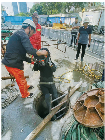
抢修疏通管网
