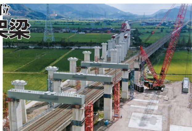
据介绍,为确保钢盖梁吊装施工始终与高压线保持安全距离,工程部门创新采用大功率辐射激光幕墙、高压近电防触电智能预警系统等设备,通过地空配合进行全方位无死角过程监控,确保吊装设备旋转位置准确和落梁精准。
