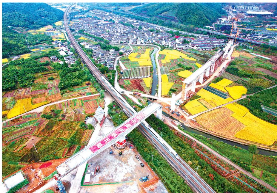
一列动车在完成转体对接的金甬铁路跨甬台温铁路特大桥下驶过。
